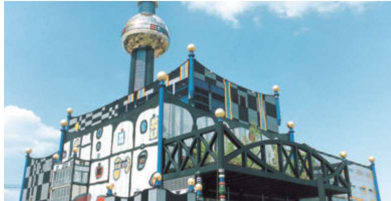
Die Fernwärme Wien wird künftig nicht nur Wärme, sondern auch Kälte durch die Stadt pumpen. Foto: Fernwärme Wien/Ernst Schauer
