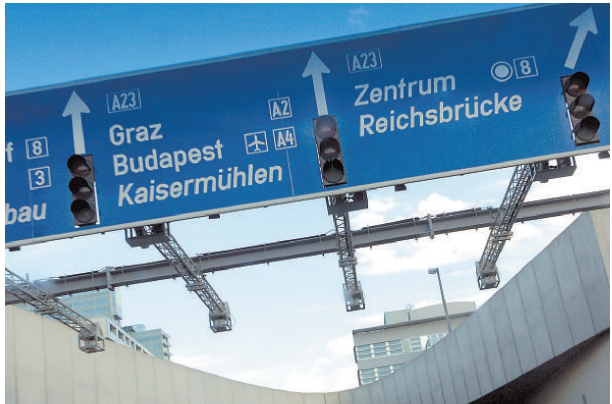
Autos lernen miteinander zu kommunizieren. Der Weg dorthin wurde durch die Freigabe neuer Funkfrequenzen geebnet. Jetzt müssen die Länder ihre Infrastruktur aufbauen. Foto: Asfinag
