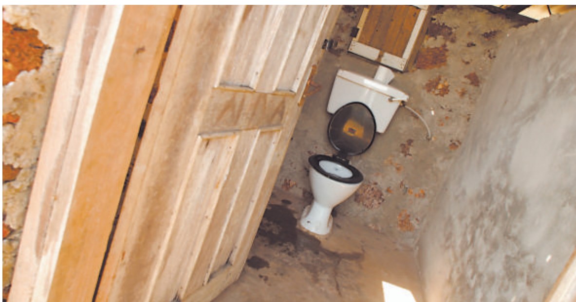
Der 19. November gilt als Welttoilettag. Dieser wurde 2001 initiiert, um auf den Mangel an hygienischen Sanitäreinrichtungen für mehr als 40 Prozent der Weltbevölkerung hinzuweisen. F.: Photos.com
