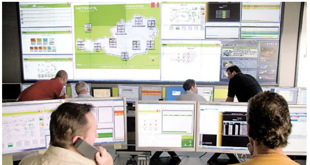
Im Network Management Center von Telekom Austria im Wiener Technologiezentrum Arsenal wird das österreichweite Datennetz rund um die Uhr beobachtet und gesteuert. Foto: Telekom Austria
